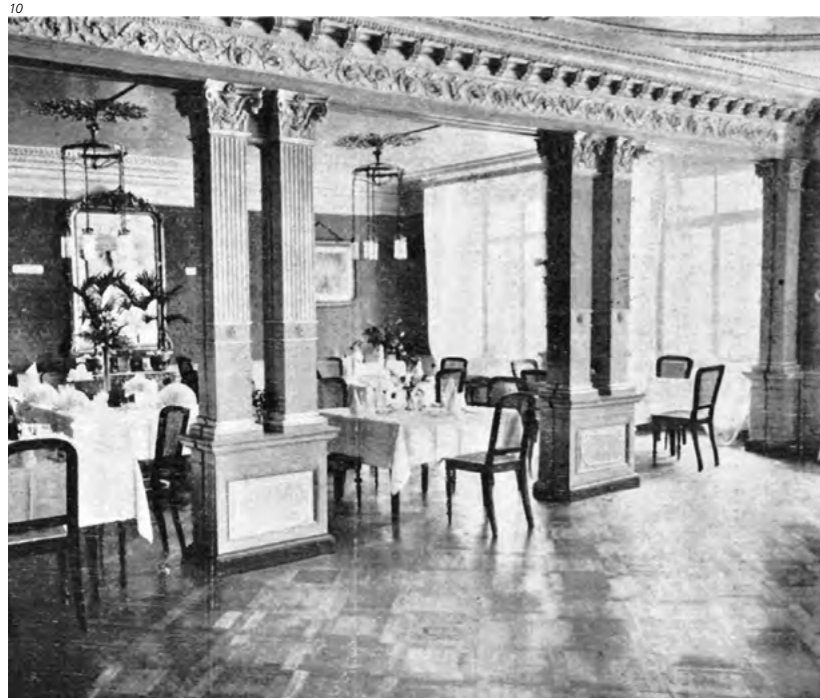
Abb. 10 Saal im ersten Obergeschoss. Aus einer Werbebroschüre von 1909.
